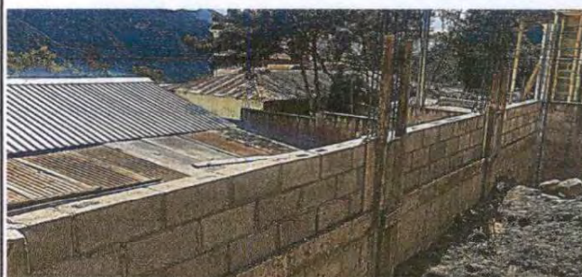
Foto 8: Reparación de muro perimetral de block y reparación de piso de torta de concreto.
