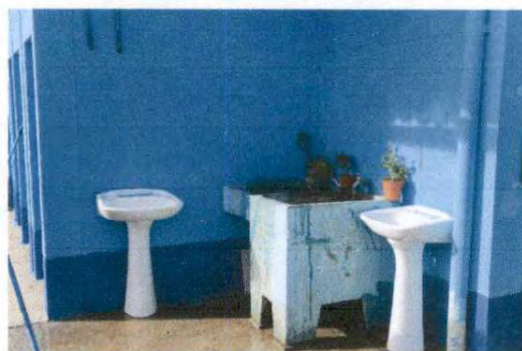
Foto 12: Instalación de lavamanos
