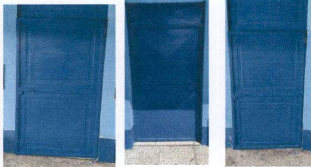
Foto1: Sustitución de 2 puertas de aulas en módulo 1 y 1 puerta en módulo 2.
