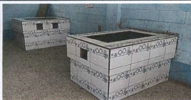
Foto 15: Instalación de azulejo en estufas rurales
