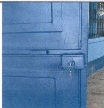
Foto 2: Sustitución de chapa en puerta de aula Módulo No. 2
