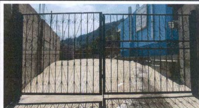
Foto 6: Mantenimiento a porton de metal de la entrada principal a la Escuela.
